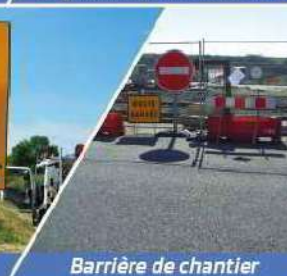
Barrière de chantier
