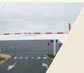
Portiques de gabarit
