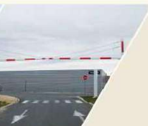
Portiques de gabarit
