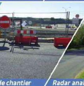
Barrière de chantier
