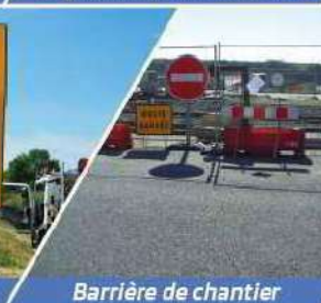
Barrière de chantier
