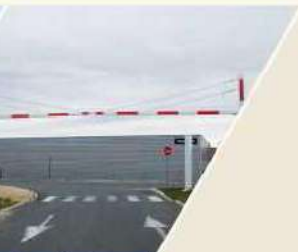
Portiques de gabarit
