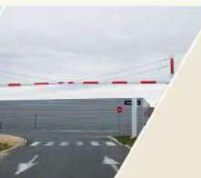
Portiques de gabarit
