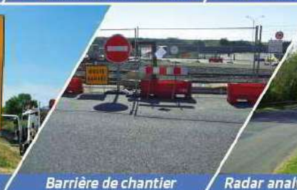
Barrière de chantier
