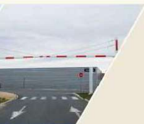
Portiques de gabarit
