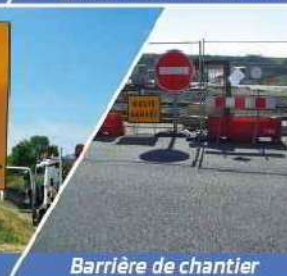
Barrière de chantier
